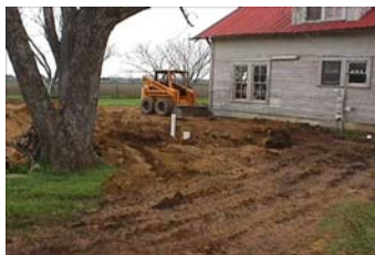
Instalación de un sistema séptica
