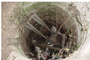
Pozo de agua abandonado
